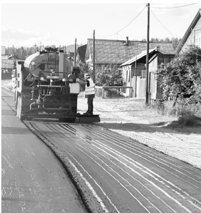
Ремонт дорожного полотна по ул. Гаврилова в пос. Николаевский
